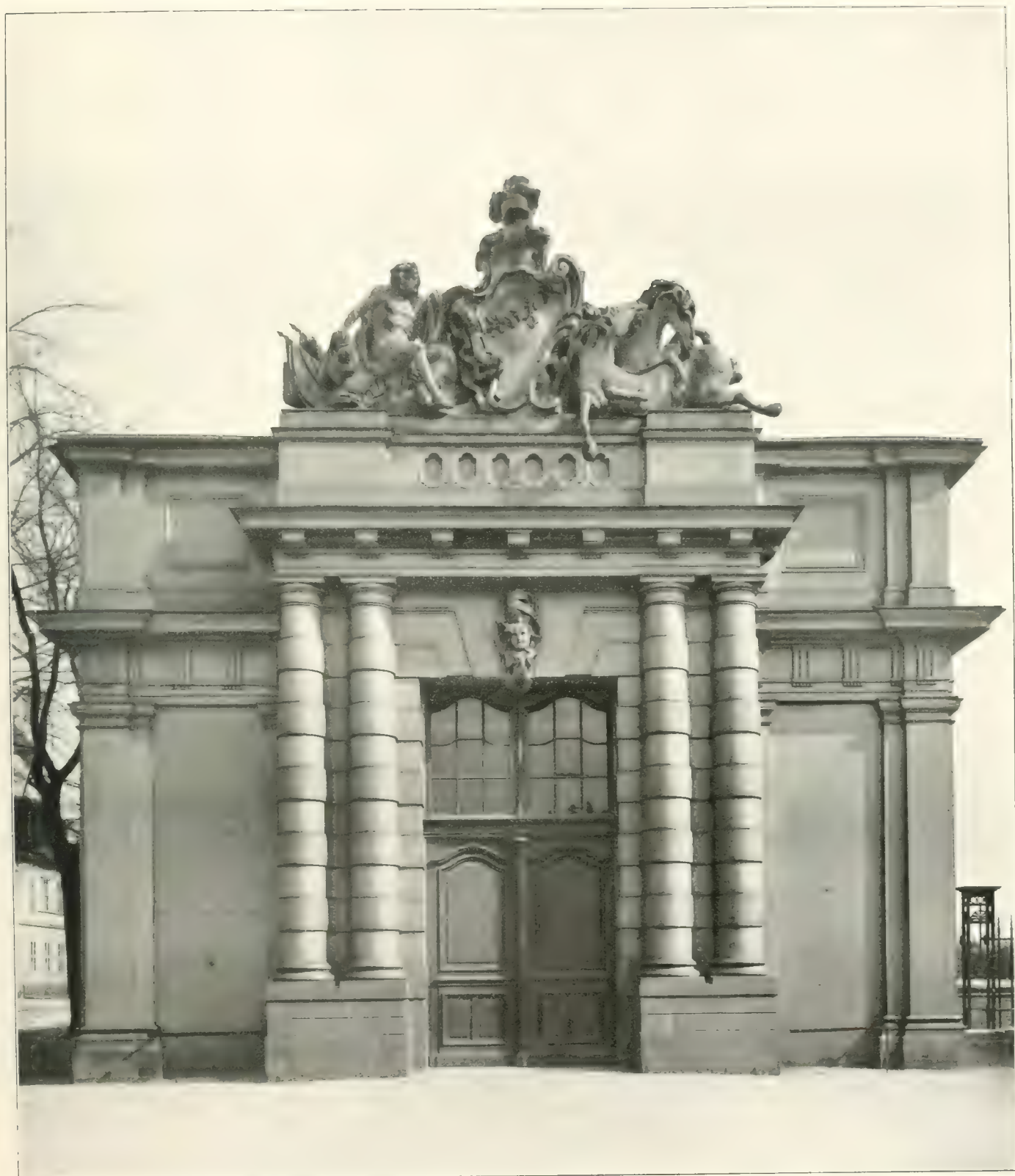
Stallgebäude am Stadtschloß in Potsdam. Knobelsdorf und Krüger 1746.
